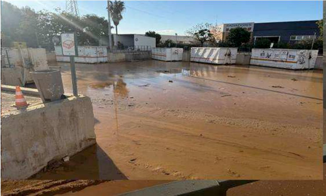
Ni la caseta del controlador del ecoparque ni las instalaciones auxiliares de depósito de residuos RAEE y peligrosos han quedado afectadas. Se esperan labores de desescombro de fango, limpieza de la plataforma y tuberías de desagüe. Si bien, serán intensas ya que se trata de uno de los ecoparques de mayor tamaño de la Red de Ecoparques Metropolitanos, todas ellas podrán ser perfectamente asumibles por la UTE concesionaria, habiendo de habilitar una partida presupuestaria especial para tal fin.
